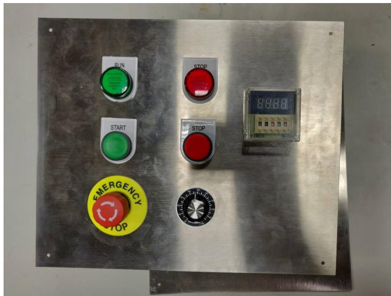
รูปที่ 3.10 ติดตั้งระบบควบคุมมอเตอร์
