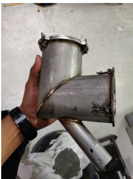
รูปที่ 3.5 เชื่อมและตรวจสอบรอยเชื่อมของถังผสมผง
